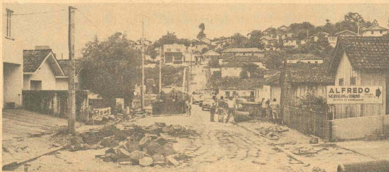
Rua Manoel de Oliveira Ramos: bueiros entupidos.
