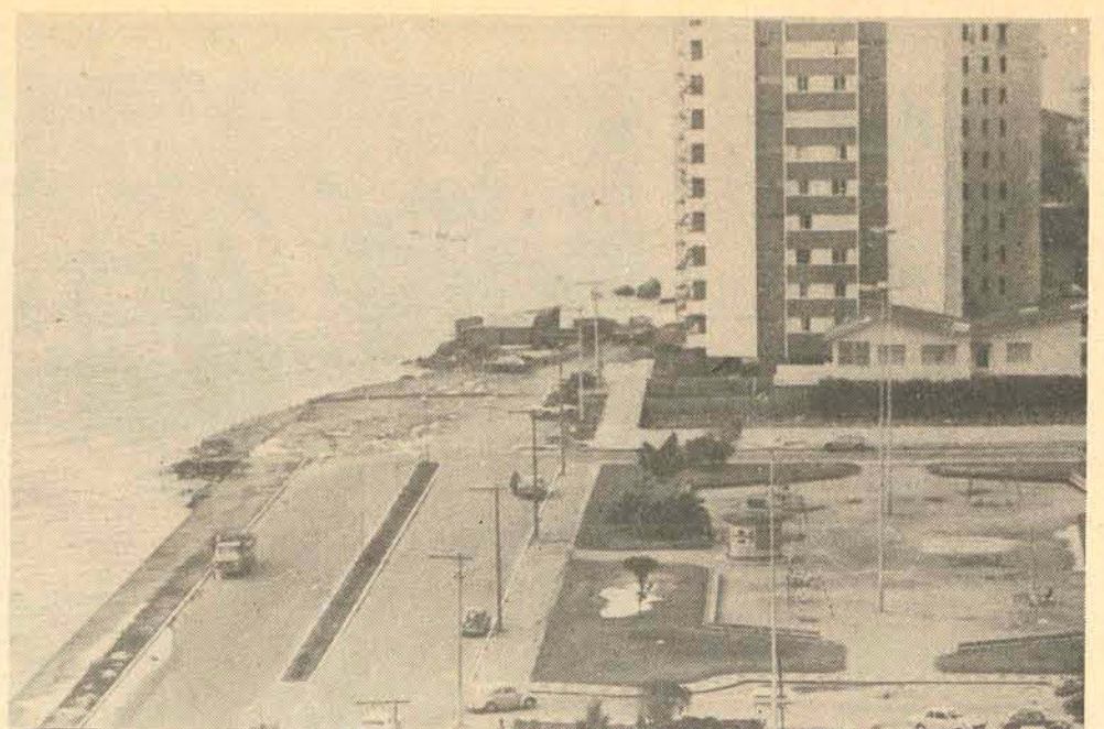
...execução dos projetos de prolongamento até a Ufsc.
