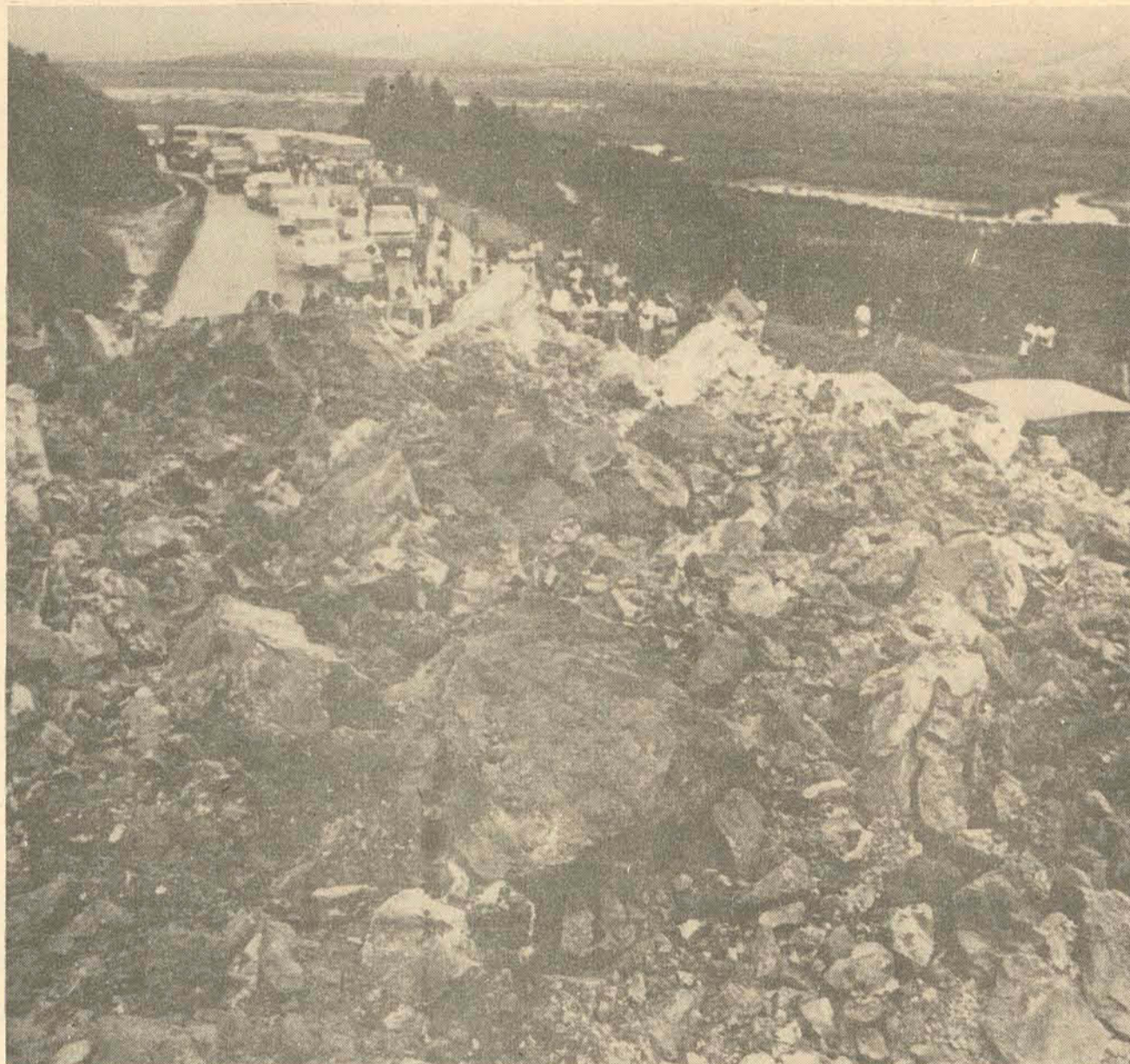
Os trabalhos de recuperação serão encerrados hoje
