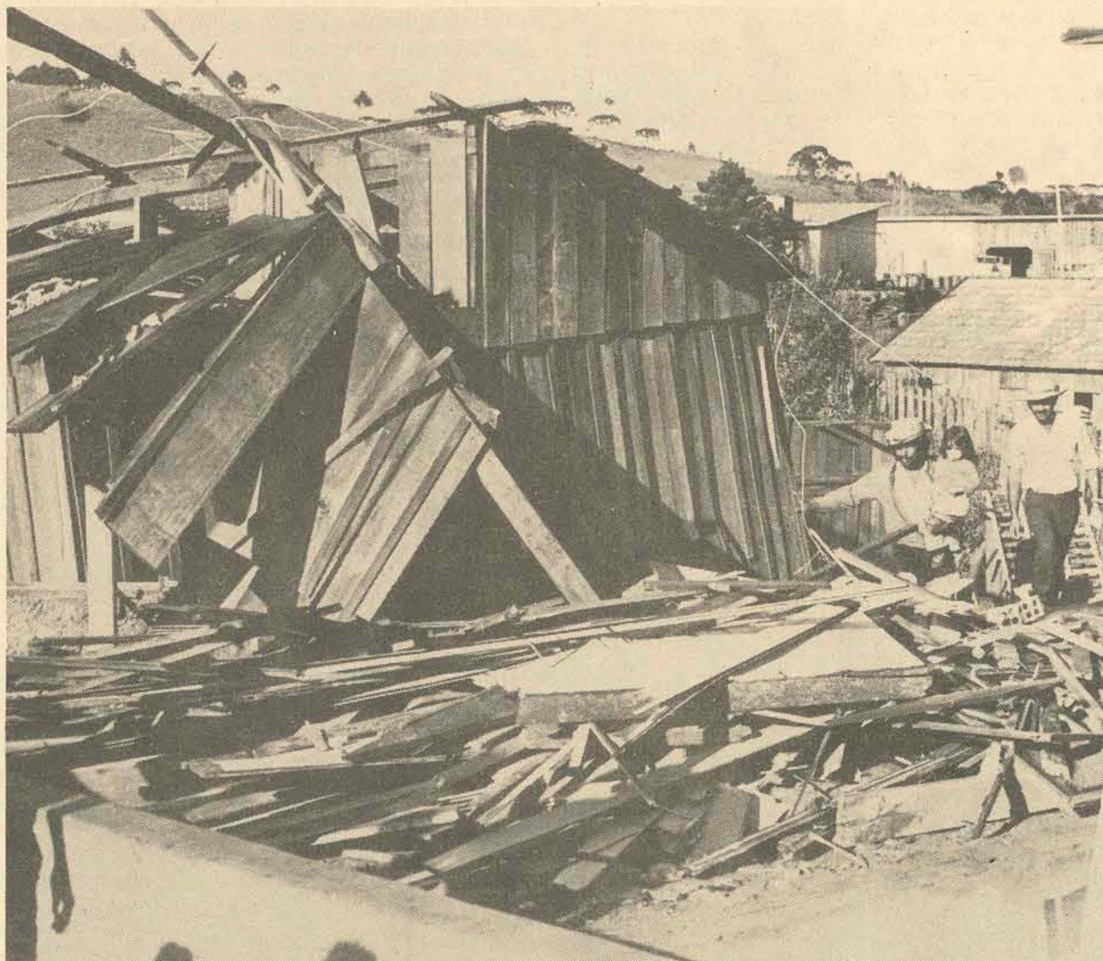
Desenhadada e desolada, uma vítima verifica os danos causados pelo vendaval que em 30 segundos castigou a cidade
