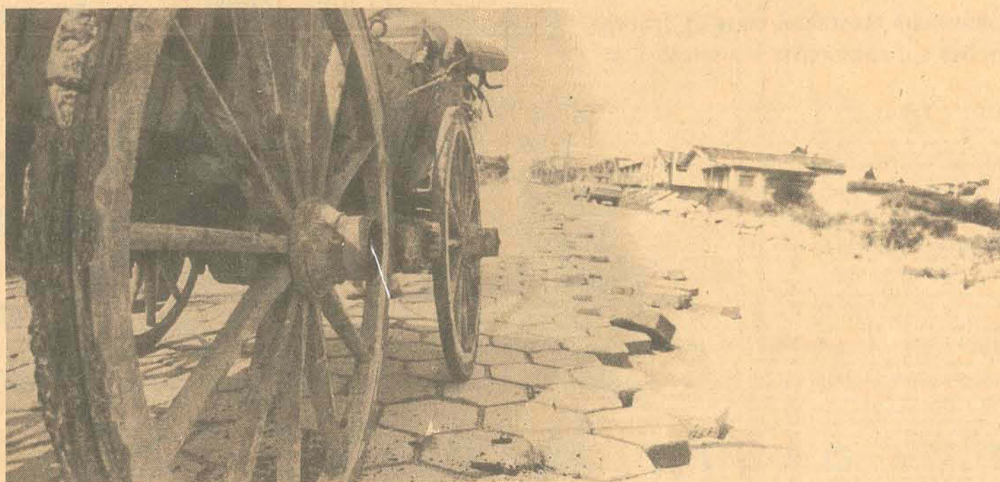
Os moradores da Rua Elesbão Pinto da Luz, no Jardim Atlântico, reclamam o reinício das obras de calçamento dessa via. Os trabalhos foram paralisados em dezembro, depois que a Prefeitura retirou as lajotas já colocadas, tendo em vista o desabamento da lateral direita da rua. As críticas tornam-se mais agudas pelo fato de parte dos serviços estar sendo custeada pelos próprios moradores (Página 16).
