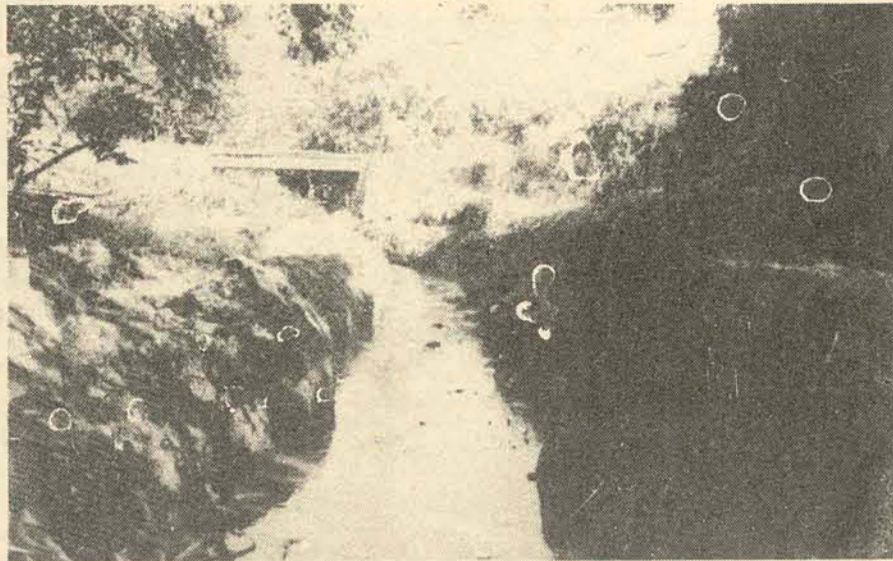
LIMPEZA DO RIBEIRÃO JARARACA, NA RUA CURITIBANOS
