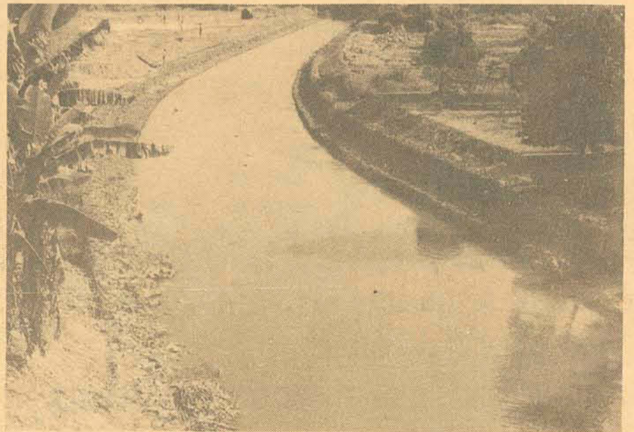
TRECHO DE RETIFICAÇÃO COMPREENDIDO ENTRE AS PONTES DA RUA CAPINZAL E A RUA ANTÔNIO ZENDRON, COM A PROTEÇÃO DE GABIÕES JÁ PRONTA.
