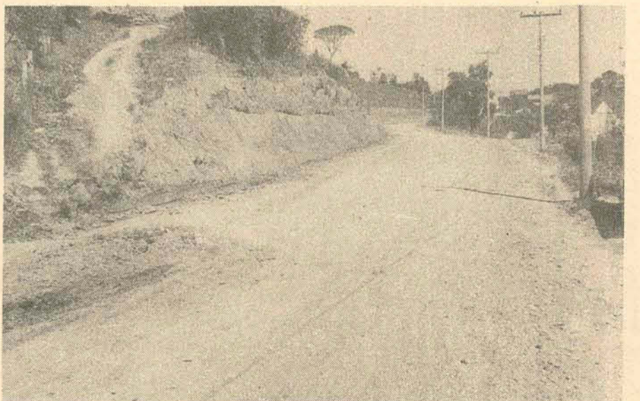
RUA 4 DE FEVEREIRO (FORTALEZA)
