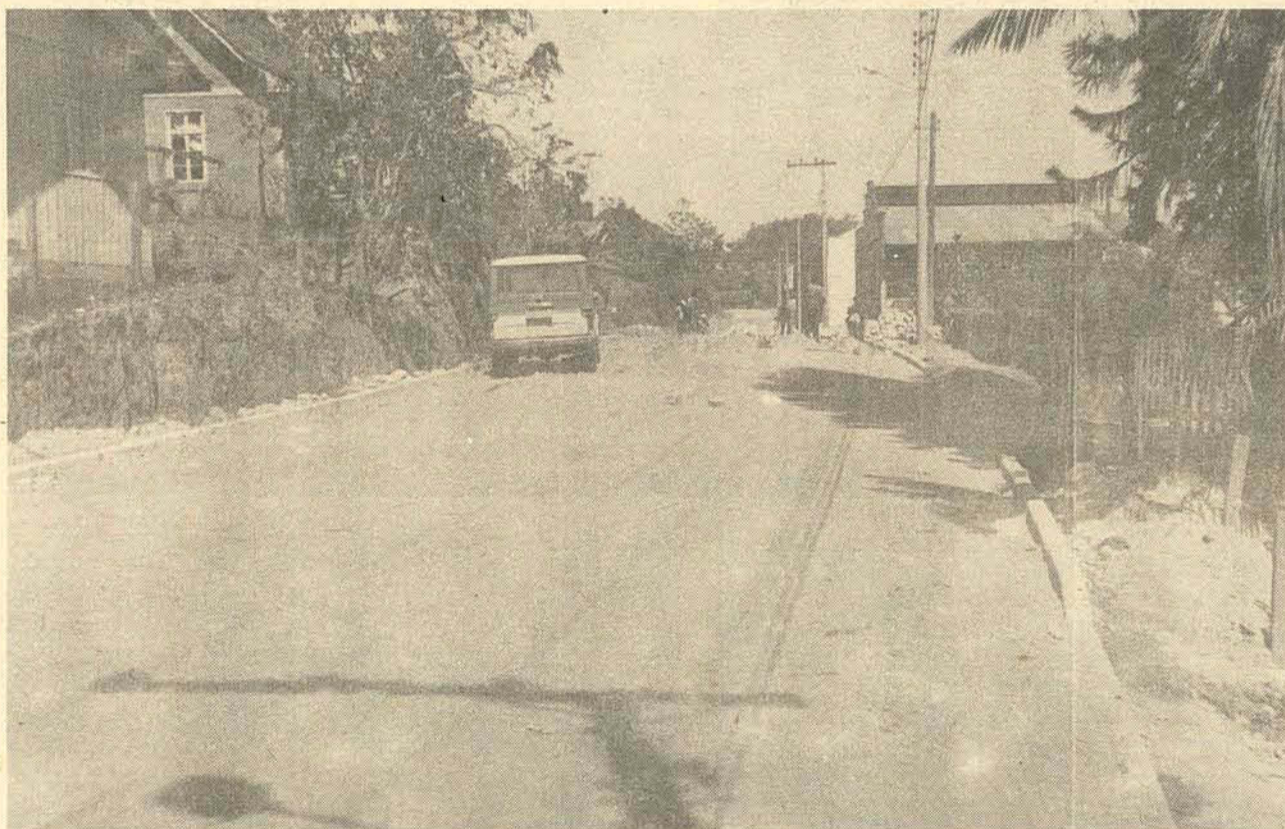
RUA FREI STANISLAU SCHAEETTE E MAIS A RUA JOSÉ DEEKE
