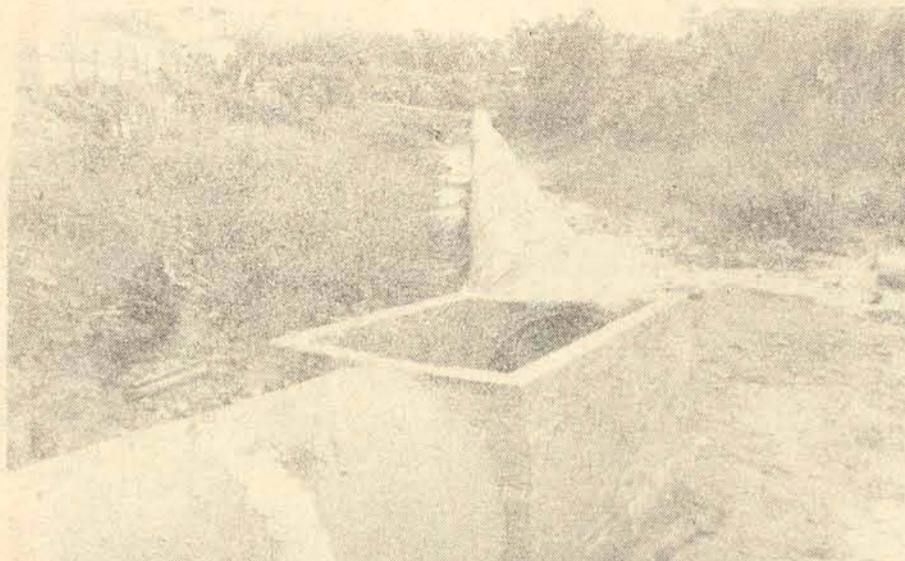
CANALIZAÇÃO DA RUA INDEPENDÊNCIA (GARCIA)
