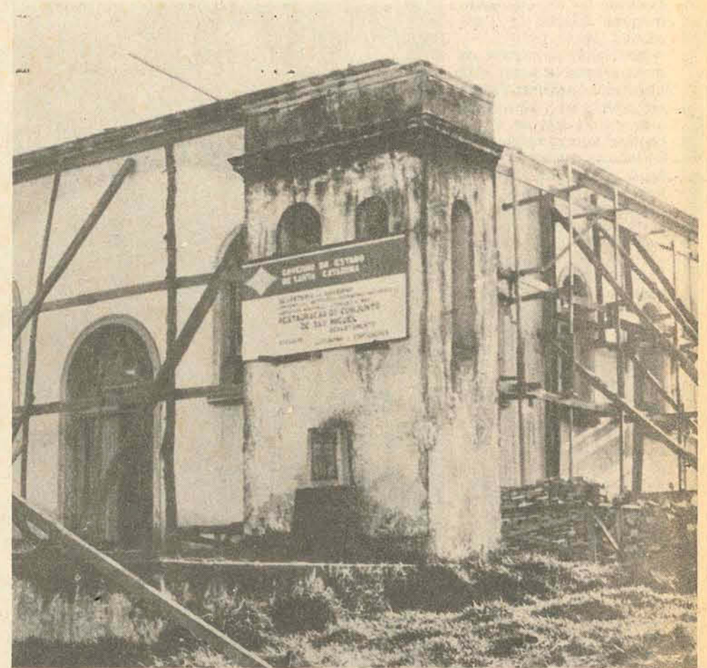
As obras de restauração da igreja se arrastam lentamente.
