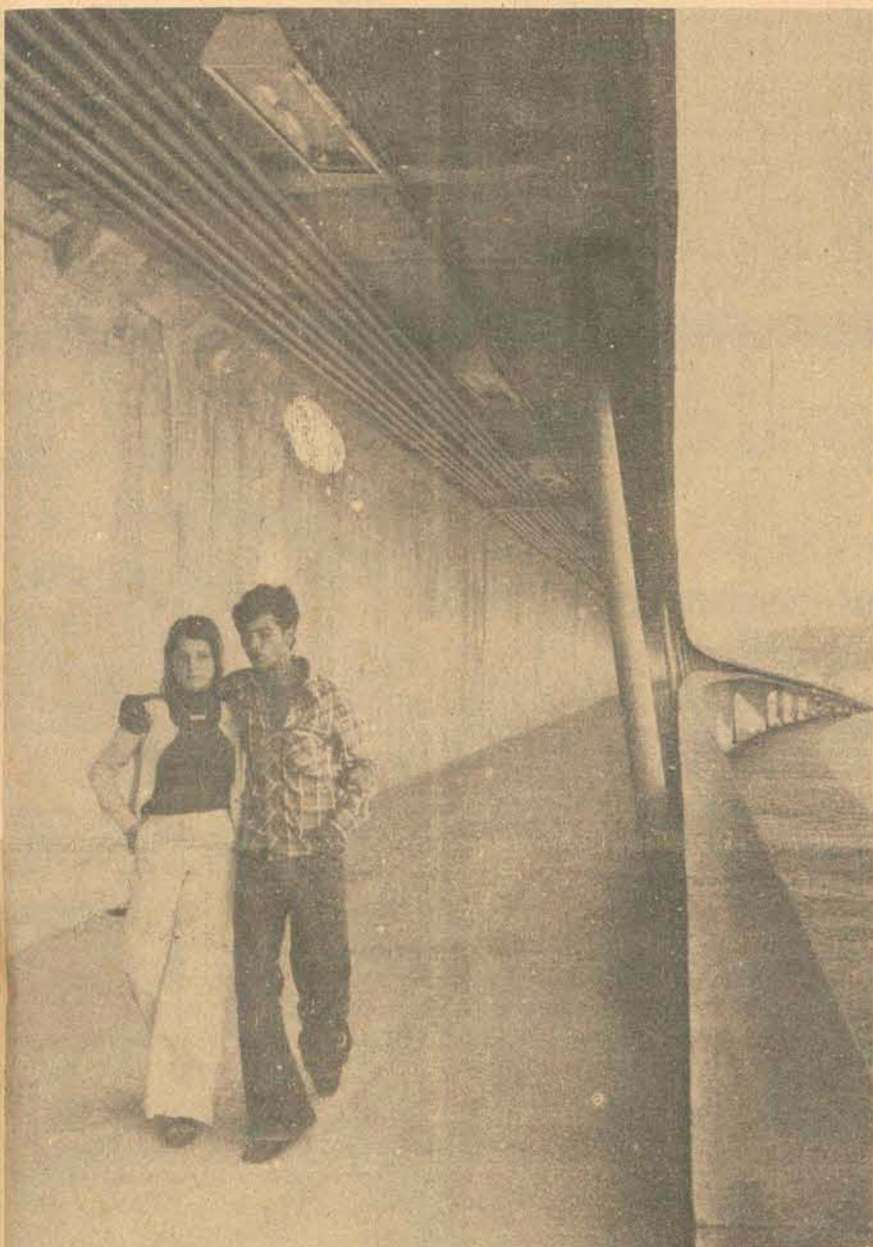
Os pedestres pouco se utilizam das passarelas para a travessia, principalmente durante a noite
