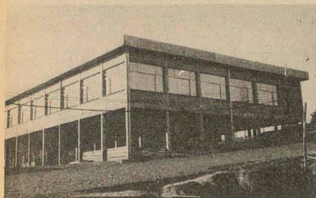
A obra, apesar de inaugurada, ainda não foi concluída
