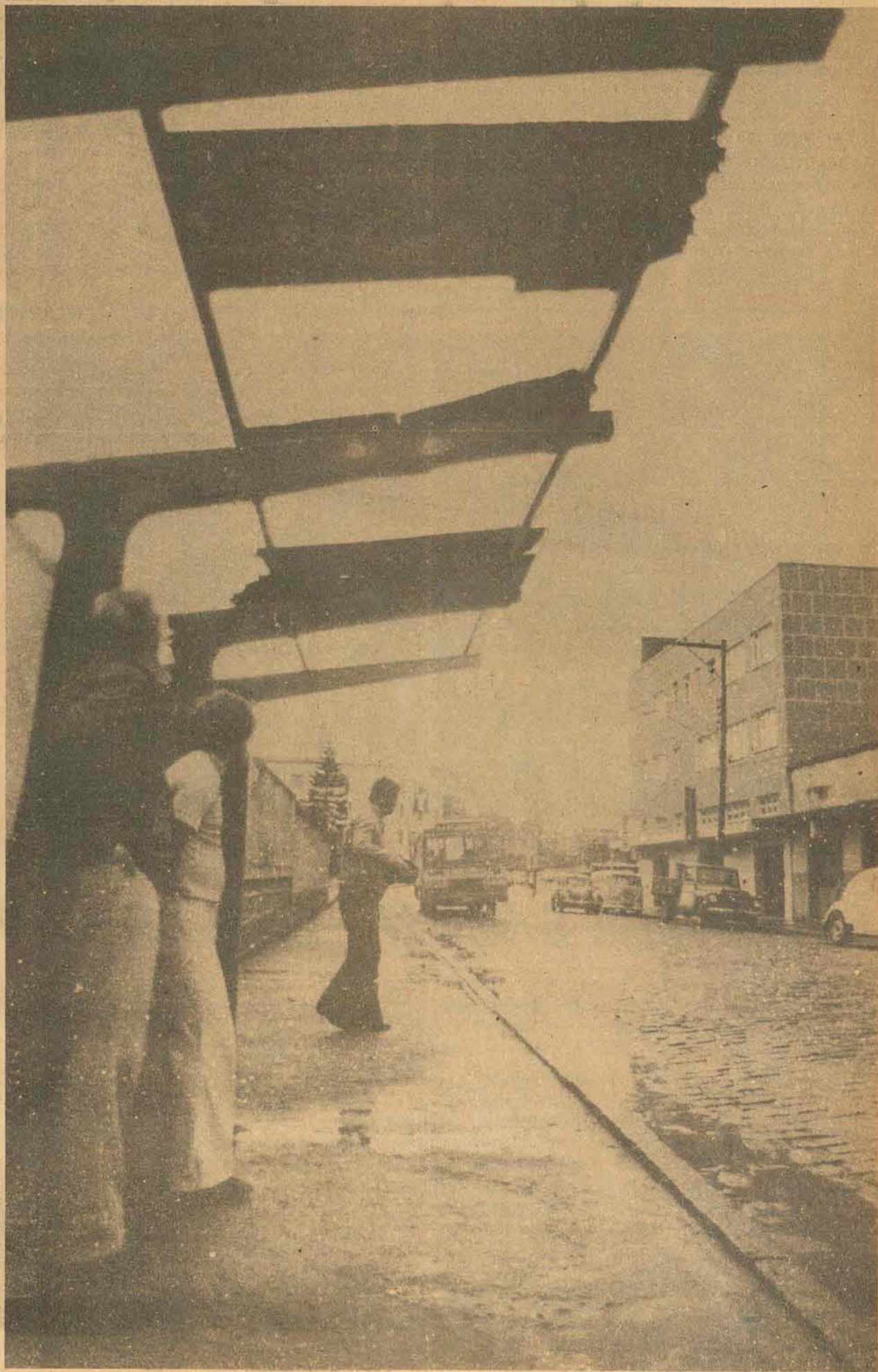
A situação dos abrigos de ônibus é praticamente a mesma em toda a Cidade. Eles de nada servem, já que estão semi-destruídos.
