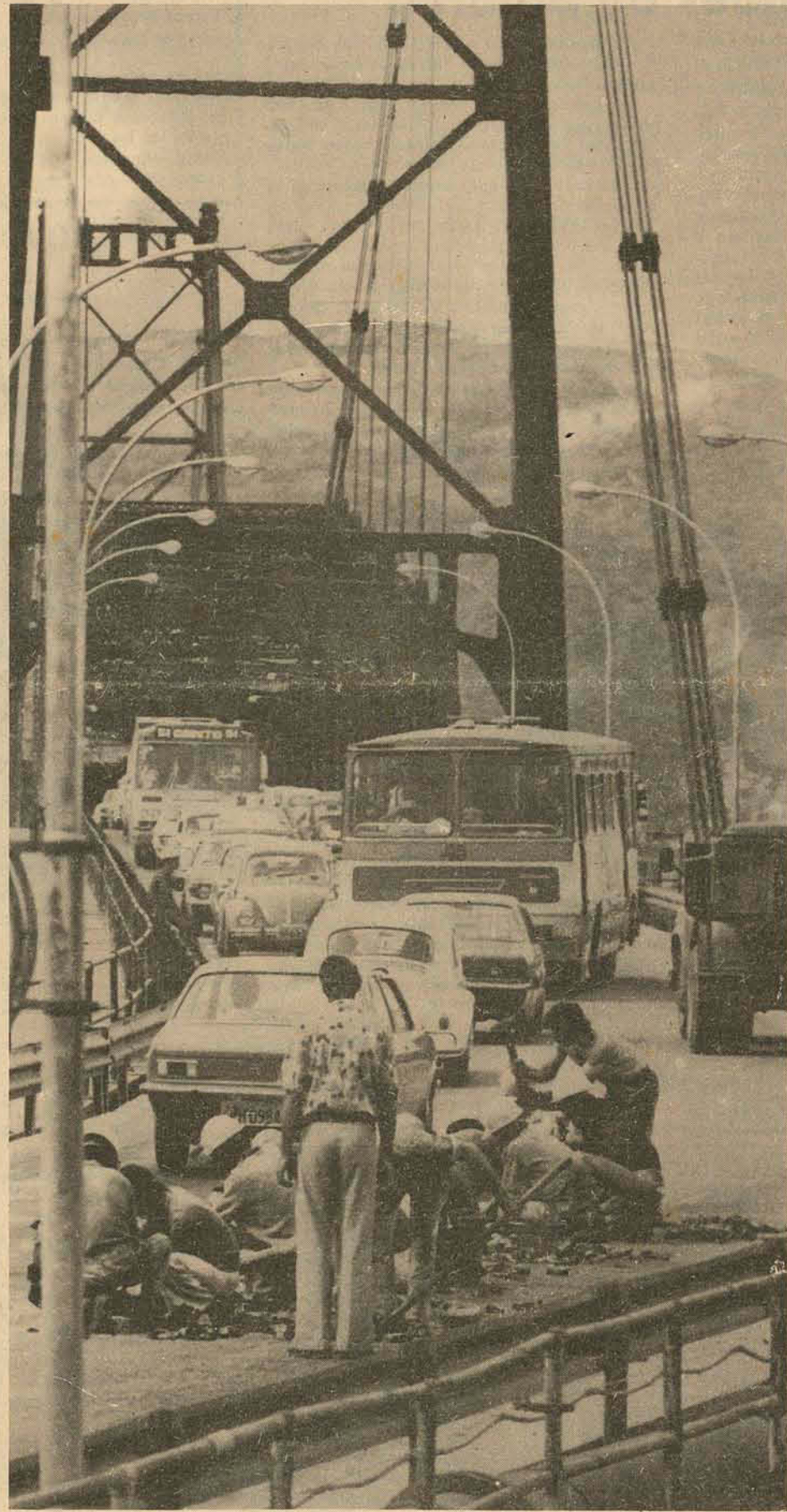
Reparando a pista em plena hora do rush, o DER obriga os motoristas a utilizarem a nova ponte.
