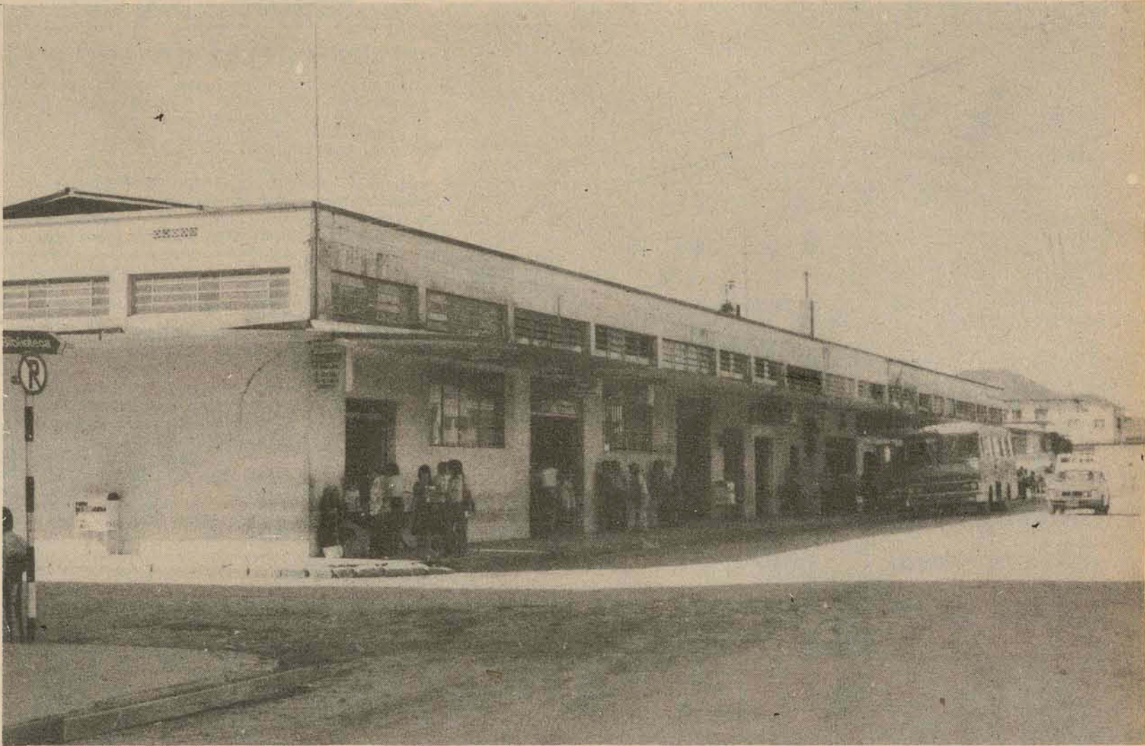
O terminal dos ônibus em Rio do Sul fica no centro.
