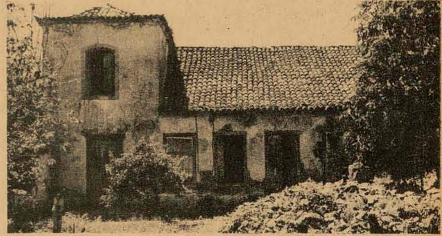
Construído por volta de 1800, o templo não foi conservado convenientemente. Suas paredes, com grossas rachaduras, comprometem a estrutura do prédio.
