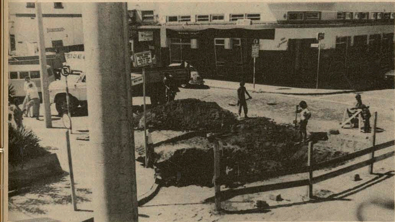
Obras de recuperação da cidade continuam.
