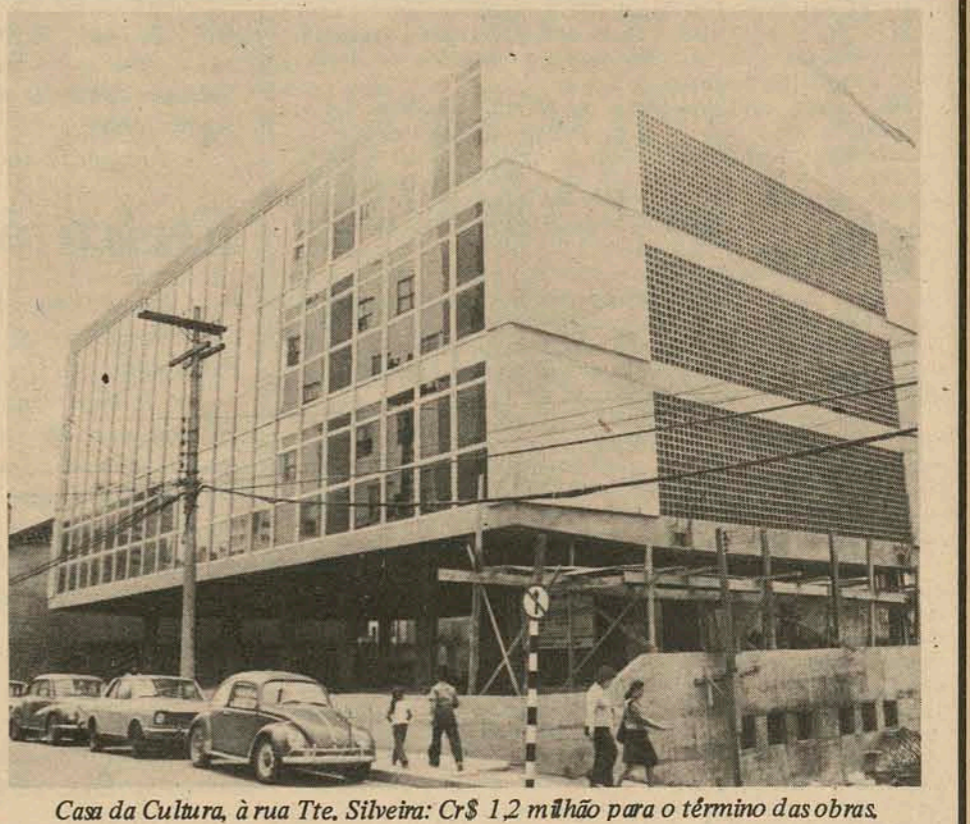
Casa da Cultura, à rua Tte. Silveira: Cr$ 1,2 milhão para o término das obras.
