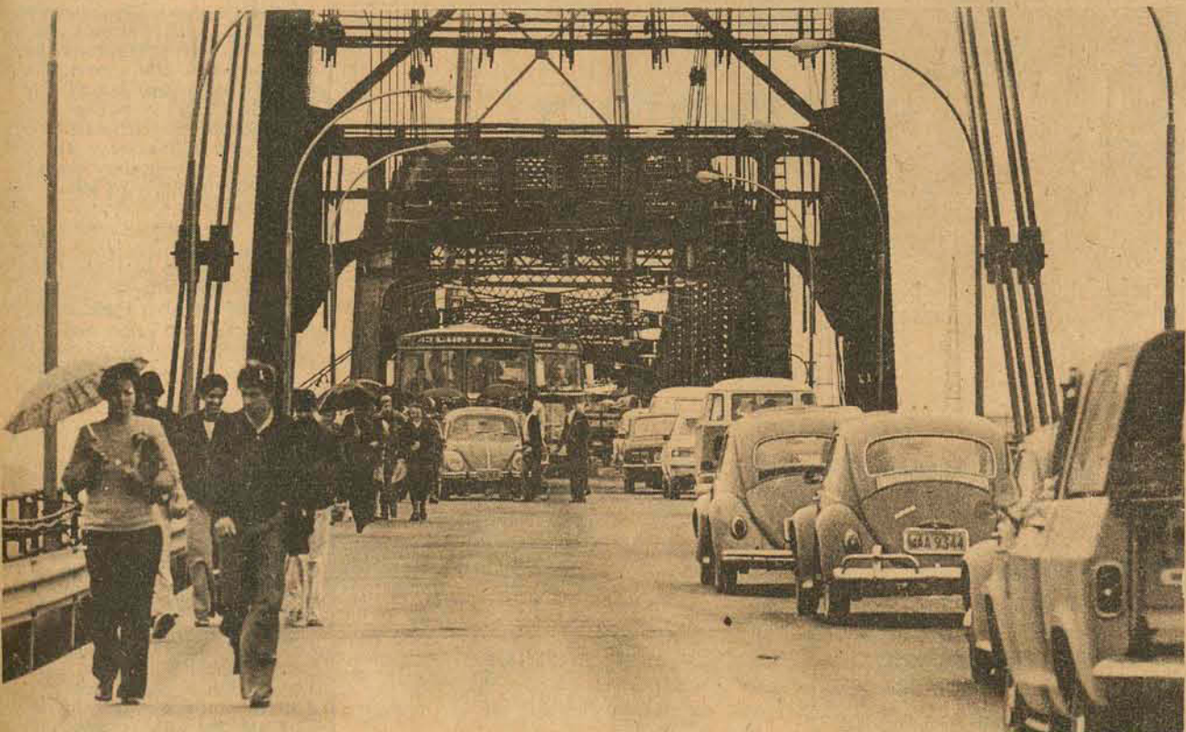
Aos poucos os motoristas vão se acostumando a utilizar a nova ponte, que ainda carece de bons acessos. Mas a velha Hercílio Luz ainda arca com um tráfego de 21 mil veículos por dia. (Pg.16)
