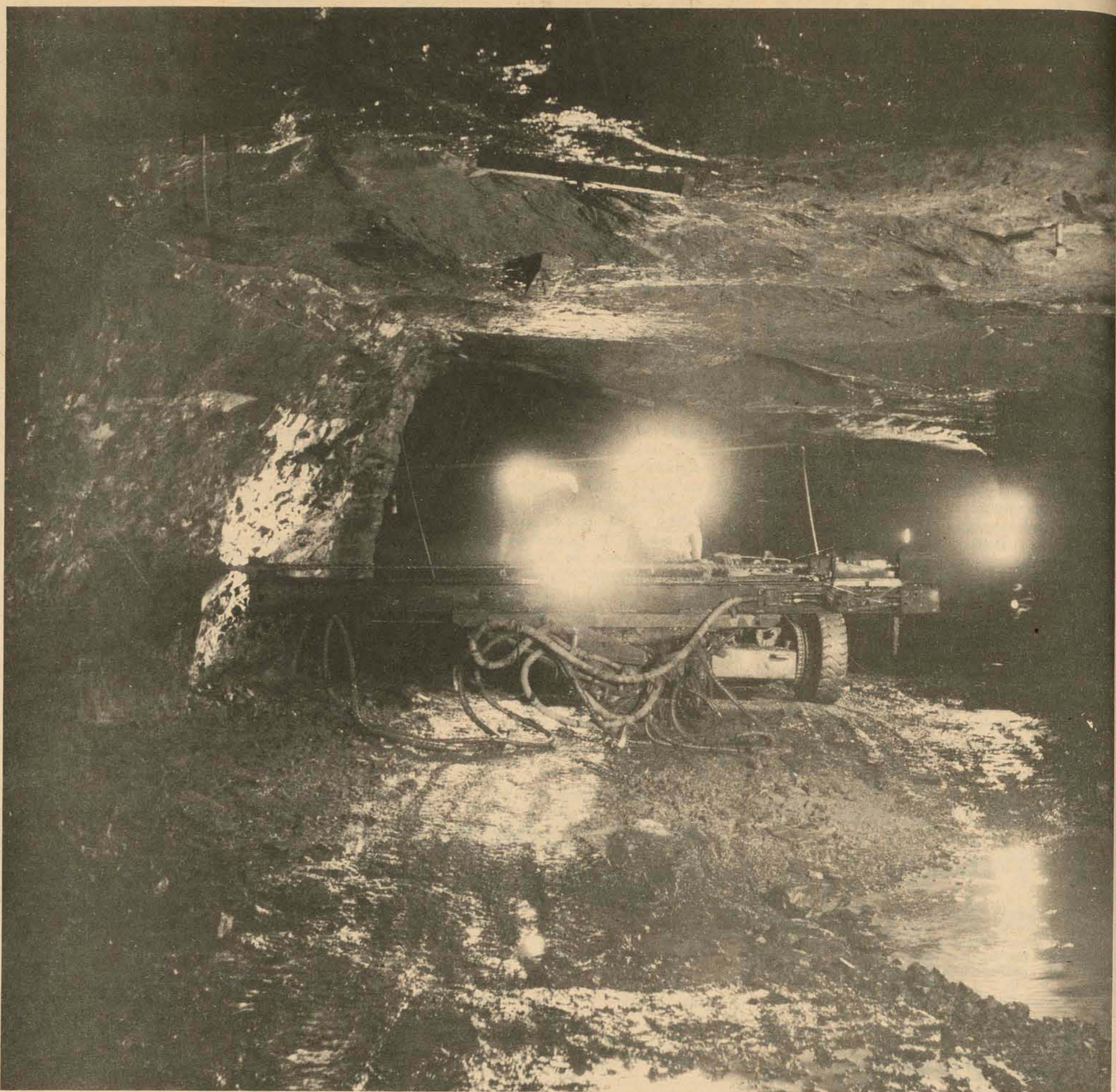
Perfuratriz hidráulica num processo mecanizado.
