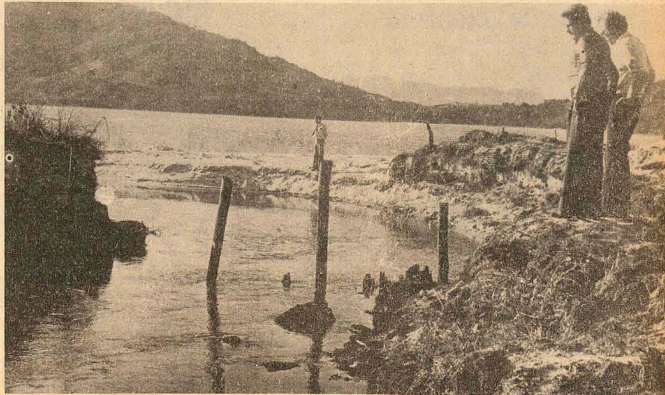
O DNOS reiniciará as obras do dique que mantinha as águas da Lagoa do Peri no seu leito natural, impedindo o escoamento. (Pag. 16).
