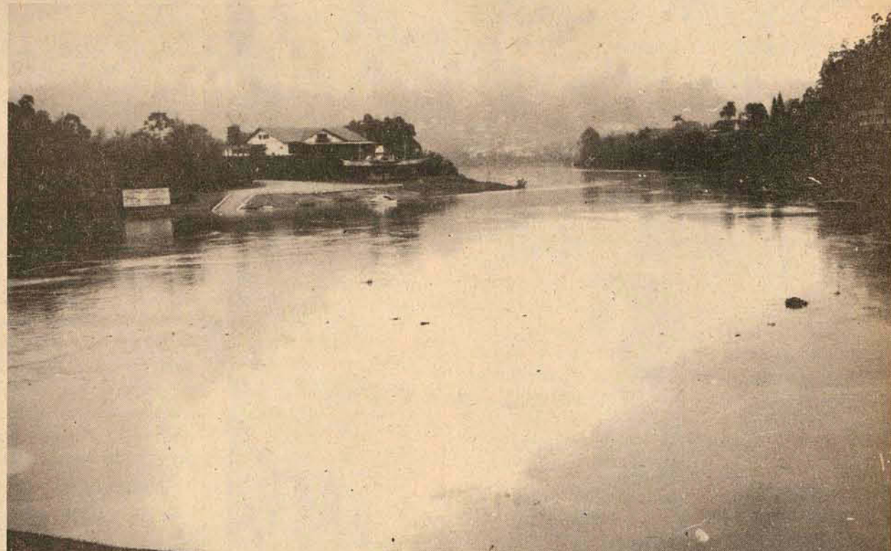
Enquanto o Ministro Rangel Reis inspecionava as obras da Barragem Sul, Blumenau vivia seu quinto dia de apreensões. Mas o rio Itajaí-Açu, que ameaçava transbordar, aos poucos retornou ao leito, quando as chuvas finalmente cessaram. (Pg. 10).
