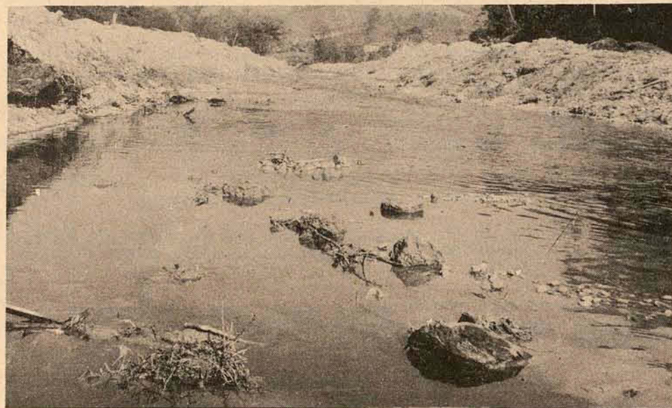
Estas obras ajudarão a proteger a cidade contra inundações.
