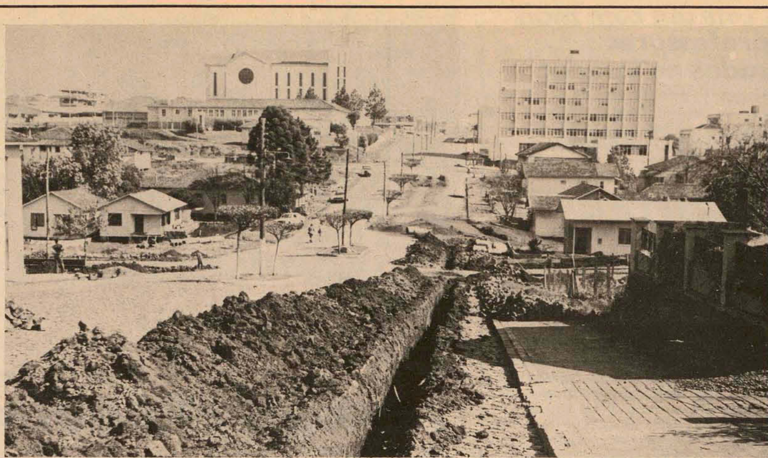
Nova rede para não faltar água em outubro.
