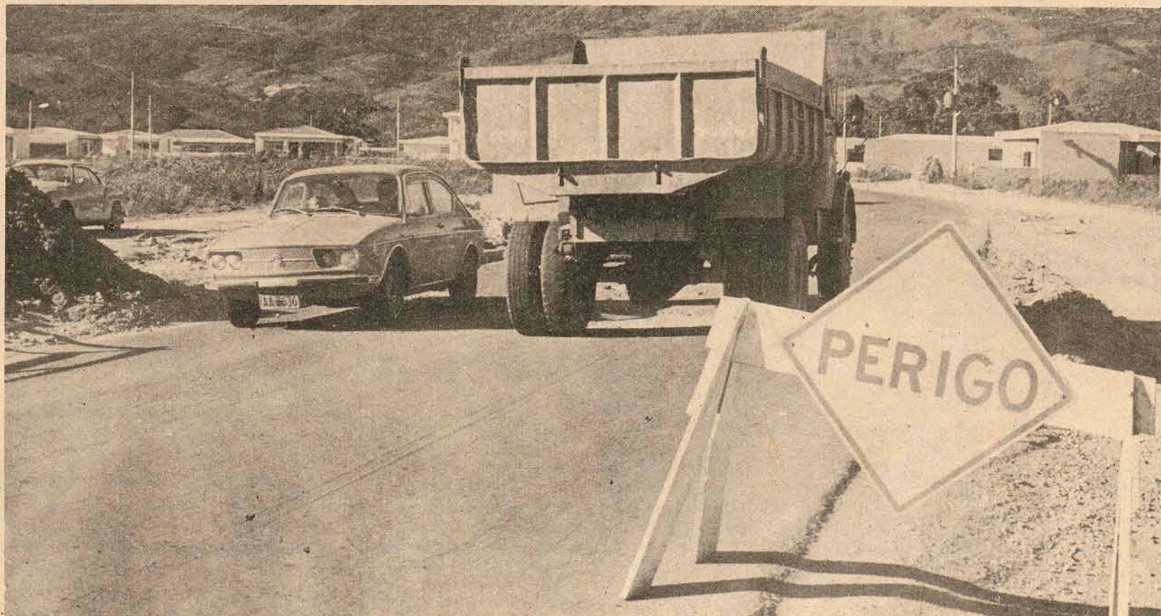
A Avenida Madre Benvenuta, no Jardim Santa Mônica, está em péssimas condições de trânsito, com o asfalto salpicado de buracos. (Pg.16)
