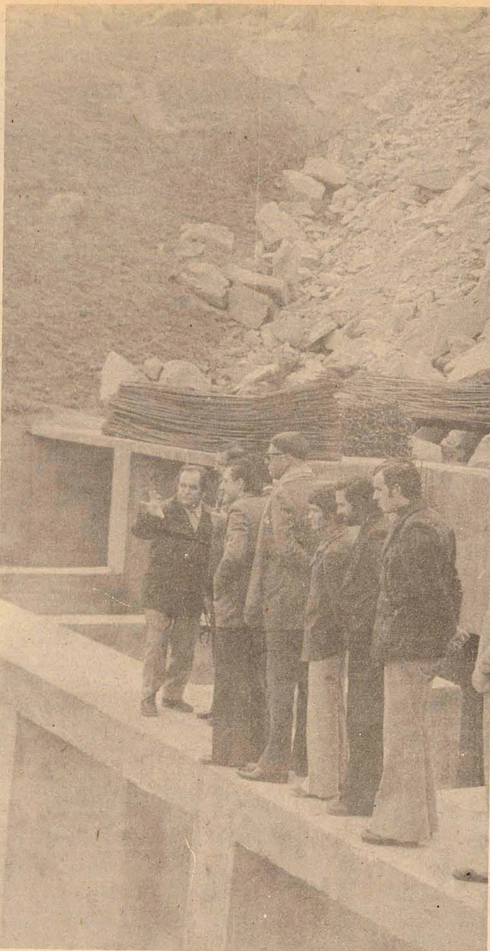
Deputados visitaram ontem as obras da barragem.
