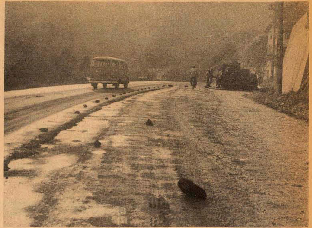
Rua das Missões com asfaltamento adiantado.
