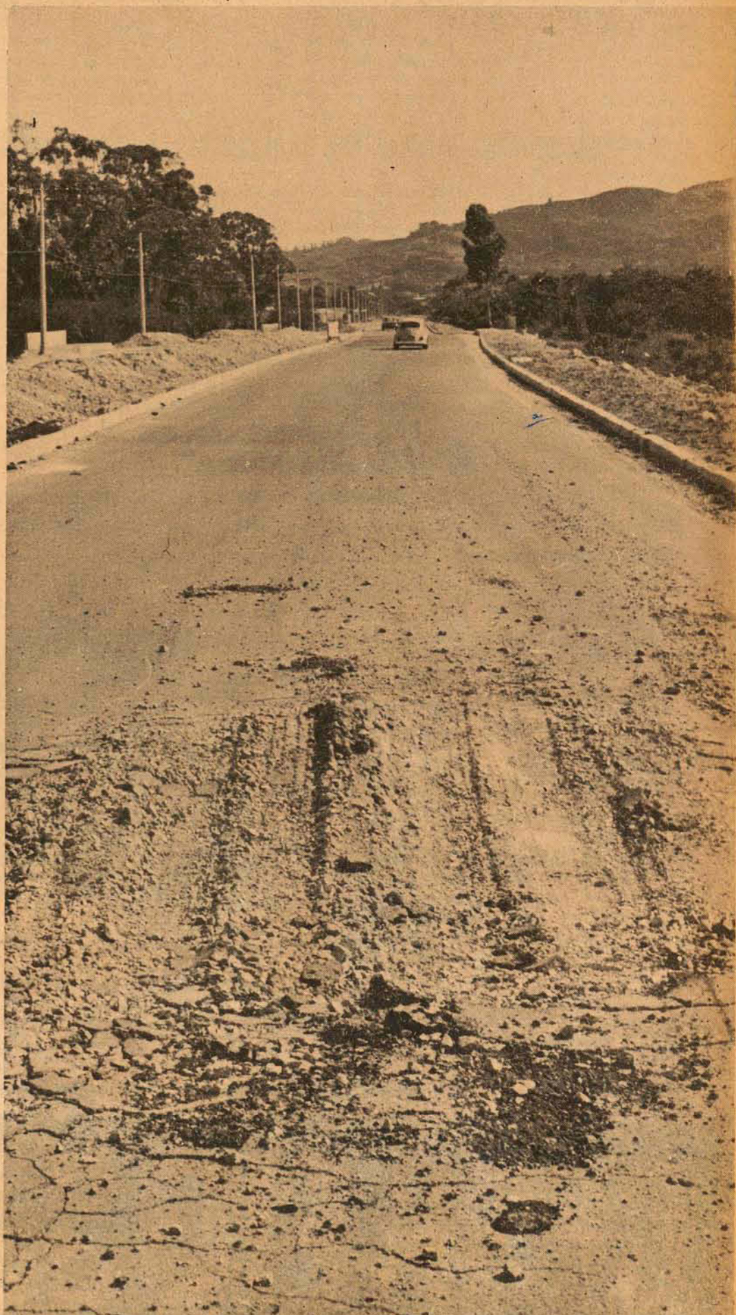
Inacabada e despreparada para enfrentar tráfego intenso, a Avenida vai entrar em obras.
