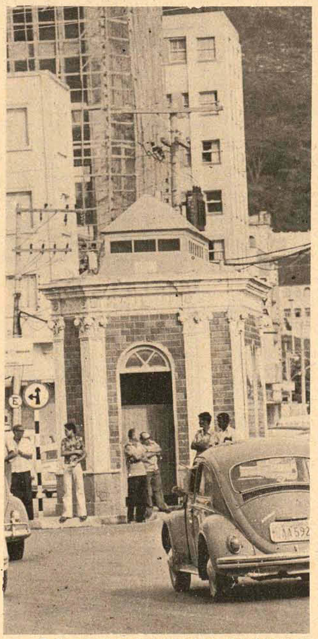
Embora só atrapalhe, não se sabe ainda se será demolido
