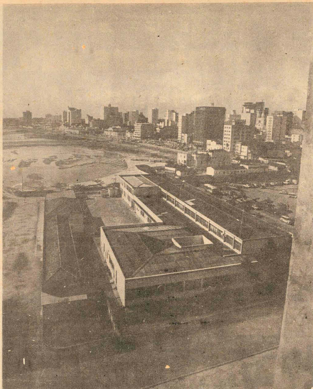
As áreas de lazer serão construídas só após a comercialização.
