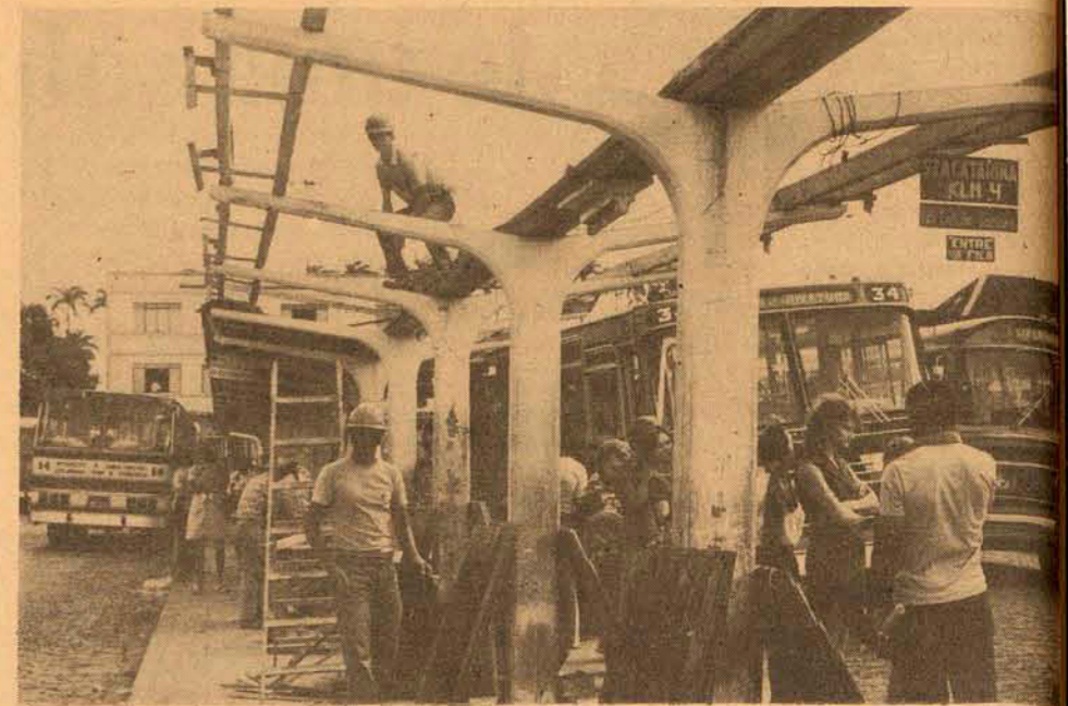
Os abrigos já não oferecem mais conforto aos usuários.
