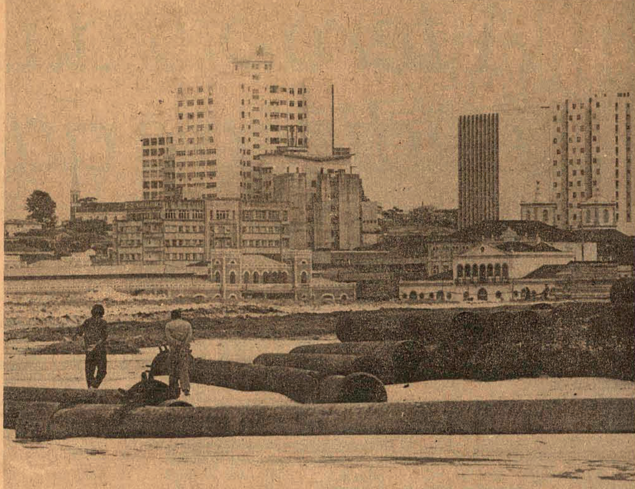
O aterro está sendo trabalhado em sua infra-estrutura, e logo receberá tubulões do esgoto.
