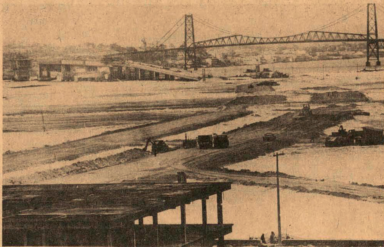
O volume de obras no aterro é bastante grande e os trabalhos prosseguem aceleradamente com vistas à sua pronta conclusão.
