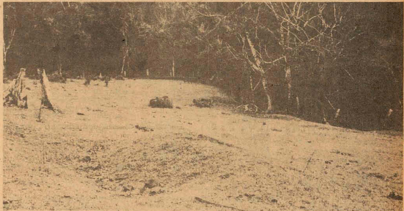
Casa subterrânea parcialmente entulhada, localizada pelo grupo de pesquisadores da Ufsc no município de São Carlos.
