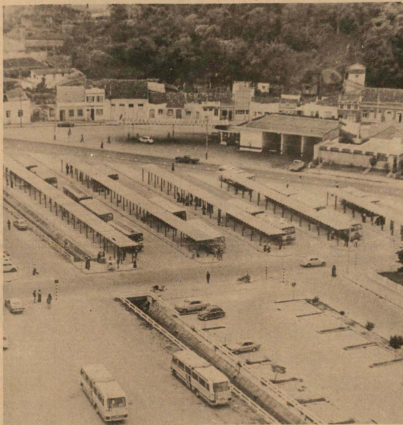
No primeiro dia, o terminal de coletivos da Prainha funcionou bem. Mas o público reclamou a falta de alguns confortos.
