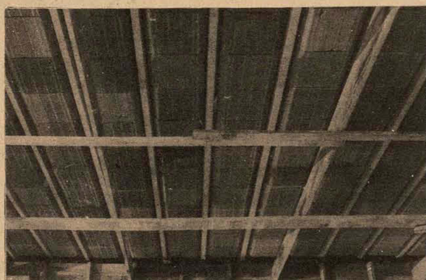
LAJE PRÉ-MOLDADA TAPUIA
