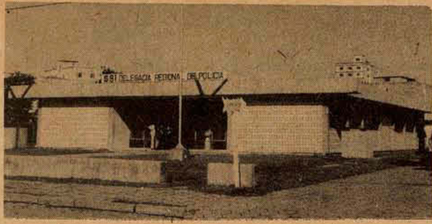
A descentralização levou à construção de prédios padrões
