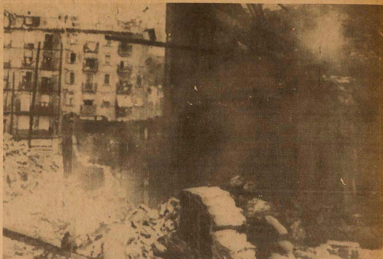
O velho edifício de 3 andares em Barcelona foi completamente destruído por um incêndio, seguido de explosões.
