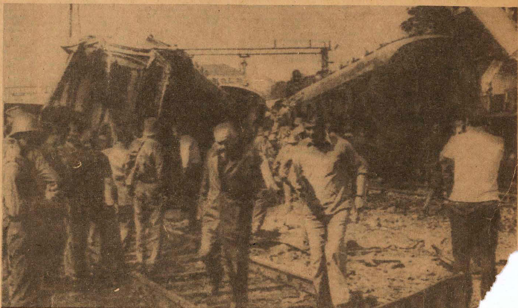
Entre os escombros do comboio restos humanos irreconhecíveis ainda estão po
