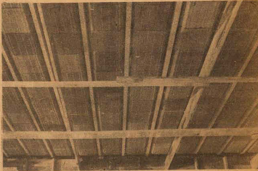
LAJE PRÉ-MOLDADA TAPUIA
