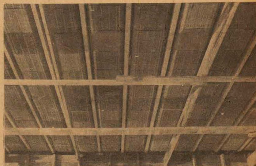
LAJE PRÉ-MOLDADA TAPUIA
