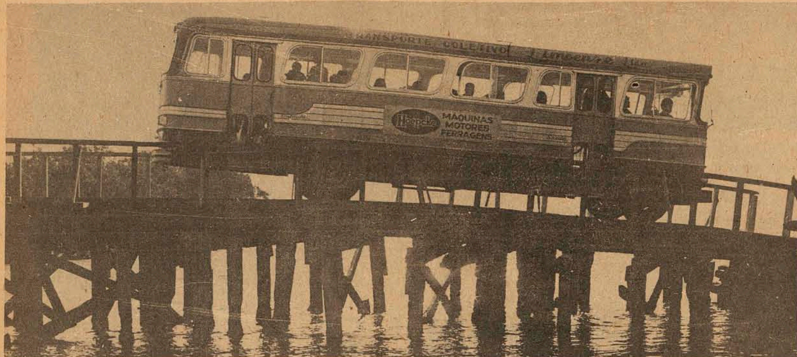
O terreno movediço foi o maior obstáculo encontrado pelo DER para construir a nova ponte.
