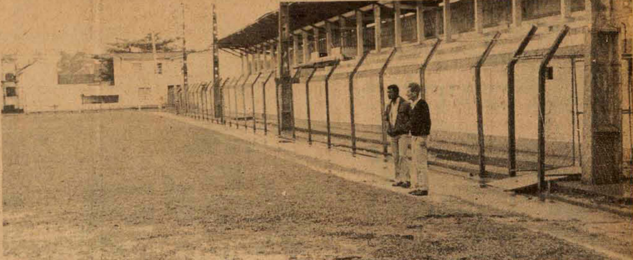
Depois de engavetado muito tempo, o projeto de reforma do acanhado Estádio Adolfo Konder pode ser executado
