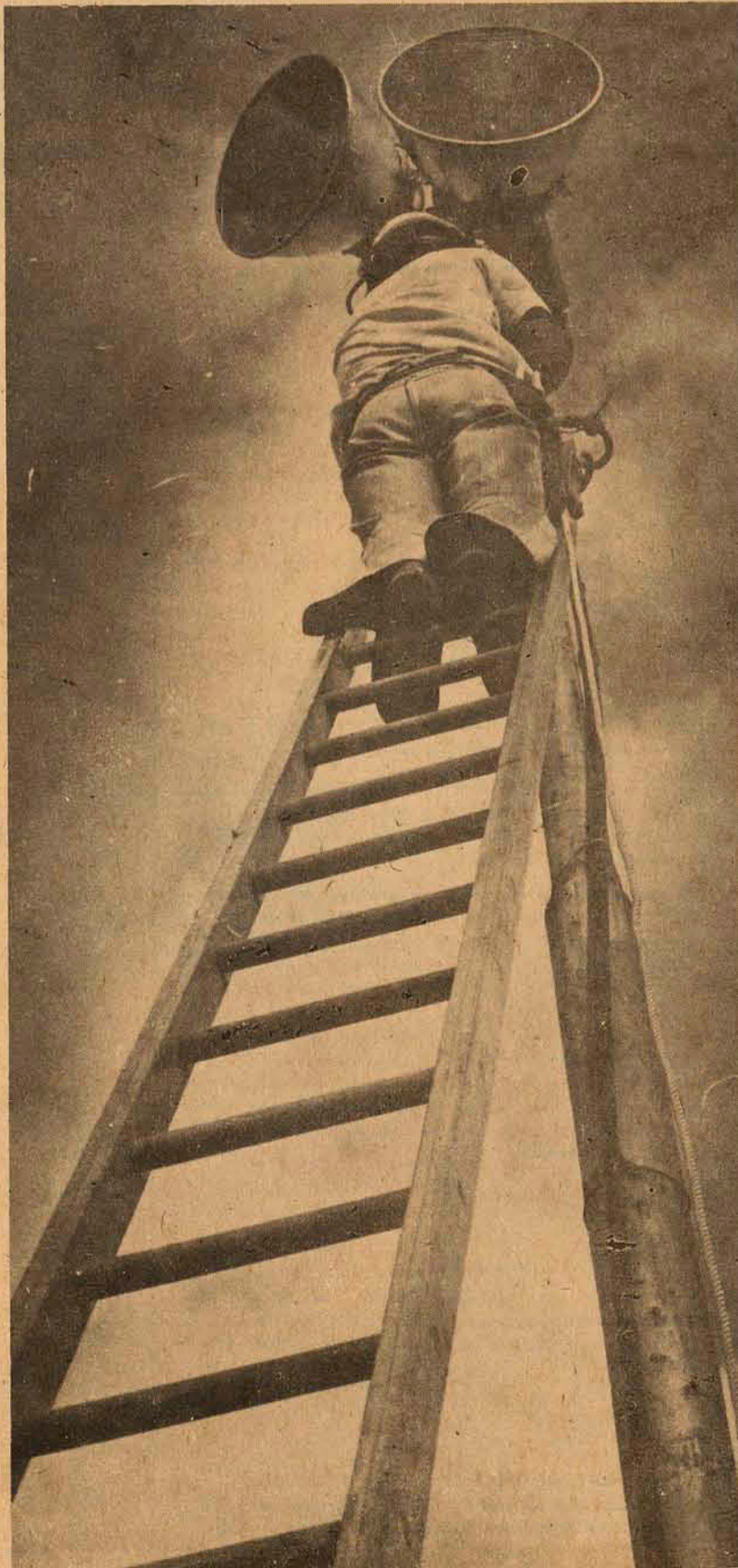
Os defeitos nos alimentadores da Subestação foram reparados domingo.
