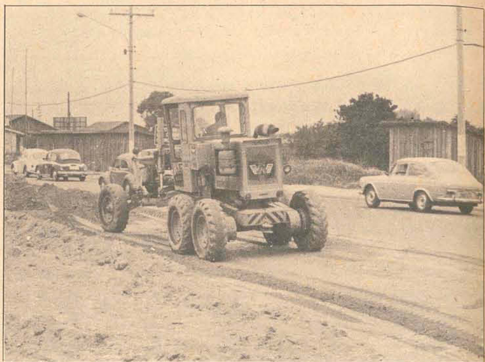
O acesso à ponte está sendo alargado, na ilha.
