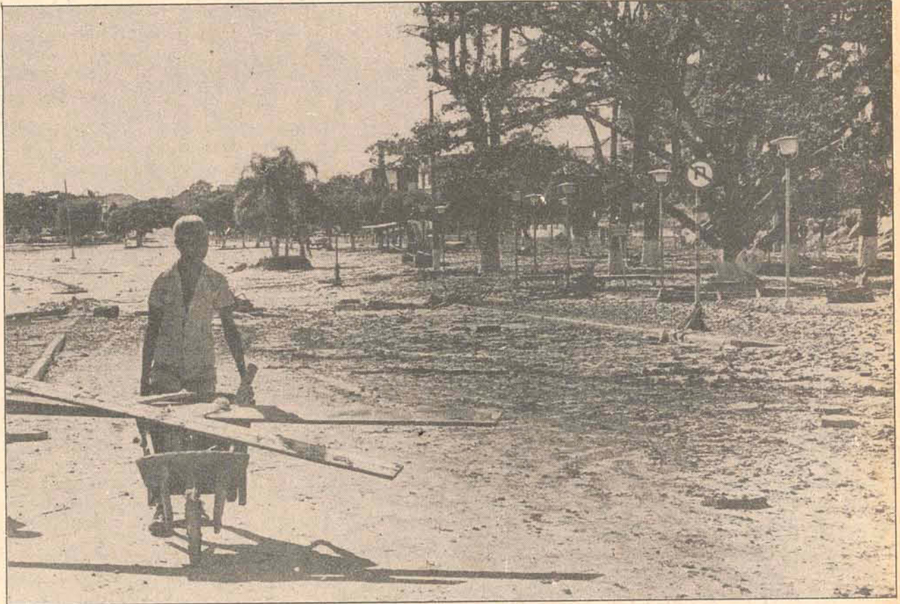
Dos escombros em que ficou transformada a cidade, Tubarão renasce para as grandes obras da reconstrução.
