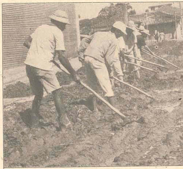
Sem máquinas, começa a remoção do lodo em Araranguá
