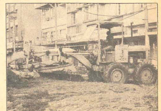
Tem início a difícil tarefa de reconstruir a cidade
