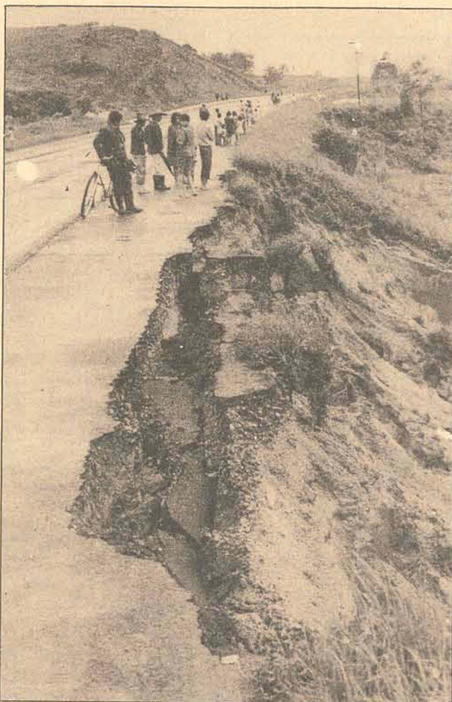
Além das barreiras, os acostamentos também deslizaram
