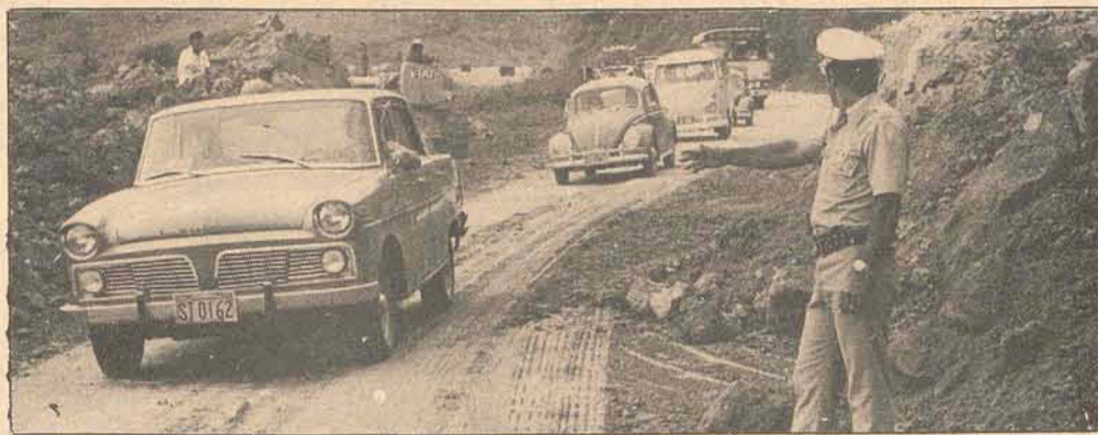
No Morro dos Cavalos, na BR-101, um deslizamento de barreira prejudicou o tráfego.
