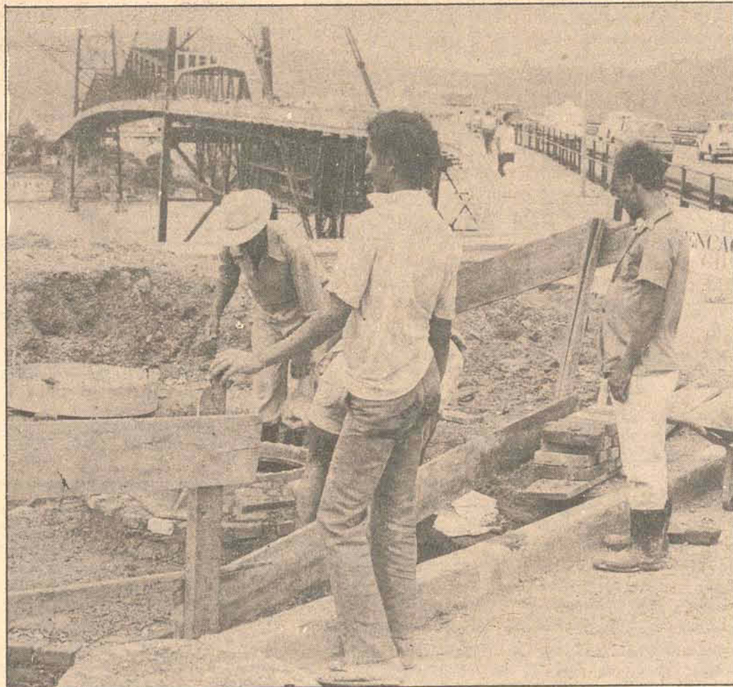
A infraestrutura exige obras de grande monta e quase sempre mal compreendidas.
