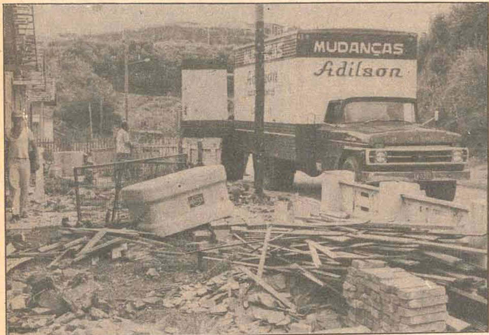
Casas demolidas e a faina das mudanças movimentam a cabeceira continental.
