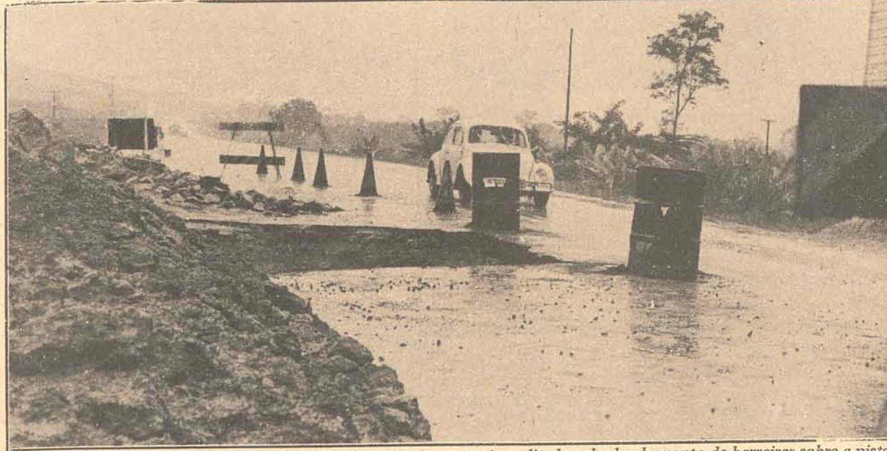
Em diversos trechos, a BR-101 ficou inteiramente interditada pelo desabamento de barreiras sobre a pista.
