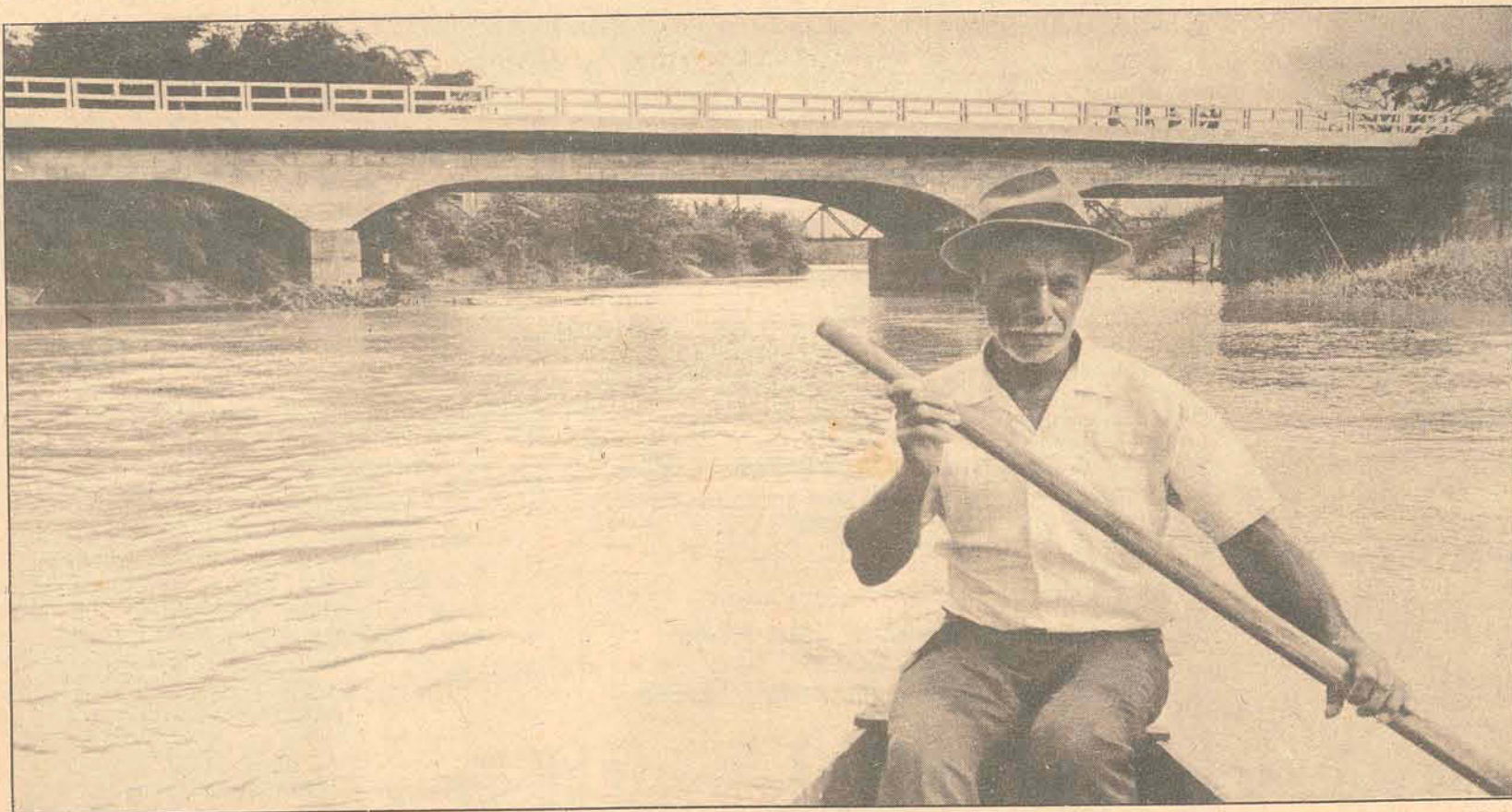
A ponte oferece tráfego em apenas uma via. Caso a situação se agrave, poderá ficar sem nenhuma. Ai, então, pára todo o tráfego.
