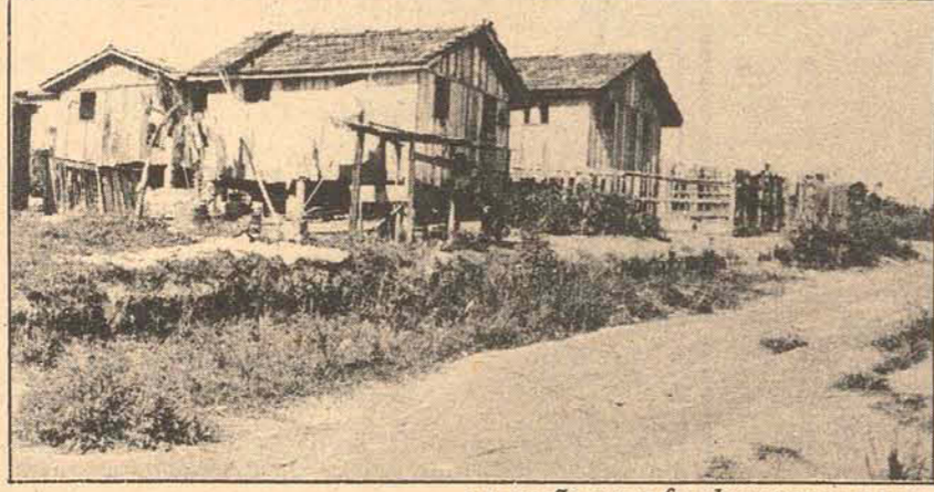
e a erosão quase faz desaparecer as ruas.
