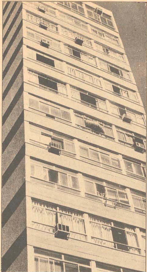
Condicionadores de ar: sobre-carga.
