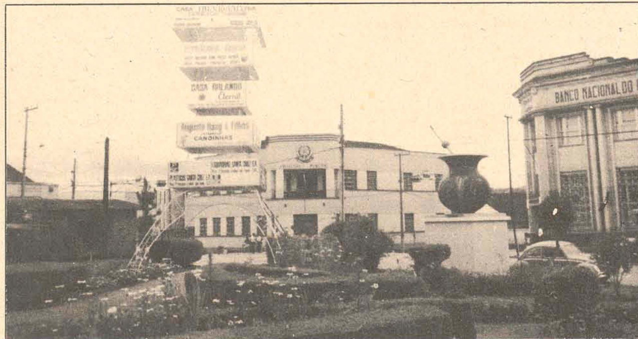
Com infra-estrutura, Canoinhas desenvolverá seu parque industrial.
