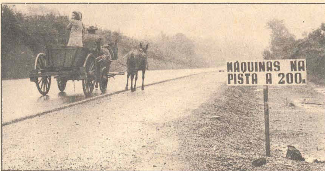
Até o final de fevereiro o trecho entre São Miguel do Oeste e Campos Novos estará concluído.
